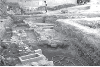
Levha 11. Foça kanalizasyon kazısı ve ostohek (Özyiğit 2013, res. 4).
