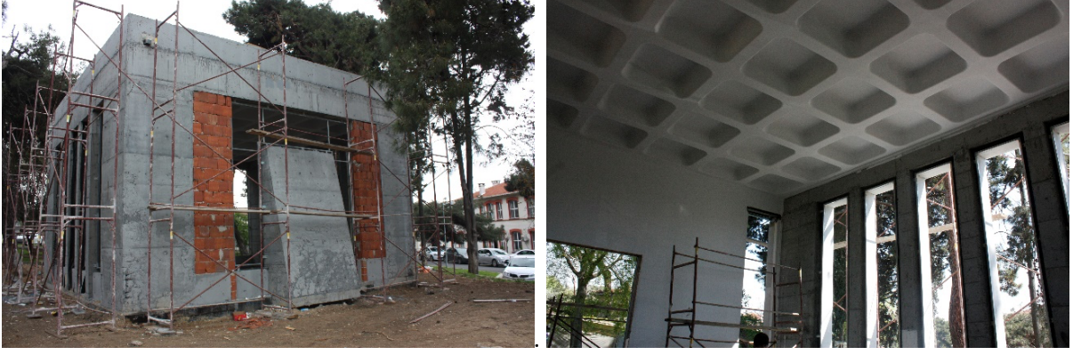
Görsel 4. Binanın yapım aşamasından dış ve iç mekândan görseller. Kaynak: MEDAC arşivinden, 2014
