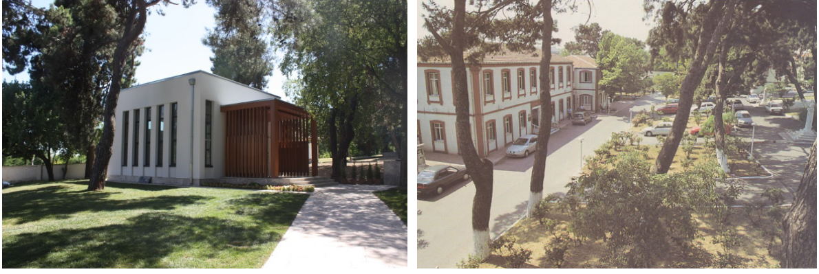
Görsel 3. Yapının kütleli formu ve çevresi ile uyumu Kaynak: Yazarın arşivinden, 2019 ve URL-2, 2020
