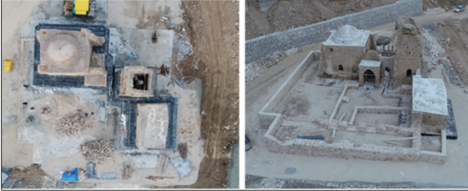
Fot. 16 (a), (b): İzolasyon uygulamaları ve özgün malzeme ve tekniğinde inşa edilen bölümler. (Er-Bu İnşaat, 2019.)
