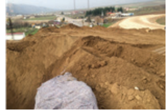
Fot. 19 (a - d): Kalıntıların sağlamlaştırılması, ayırıcı geotekstil keçe ve dolgulama işi. (Er-Bu İnşaat, 2019.)
