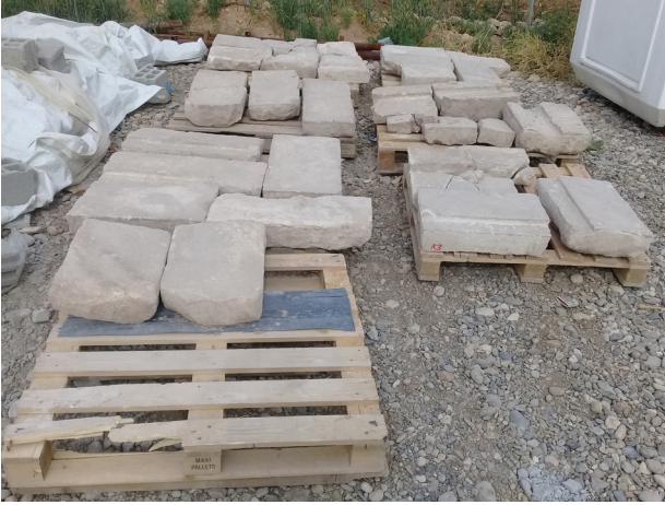
Fot. 8: (a), (b). Numaralandırılan elemanlar ve ahşap taşıma paletler (Er-Bu İnşaat, 2018.)
