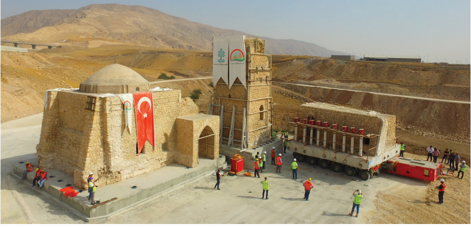
Fot 14: Yeni yerinde türbe ve minare ile taşınan giriş yapılarının nihai konuma yerleştirilmesinden görünüm. (Er-Bu İnşaat, 2019.)
