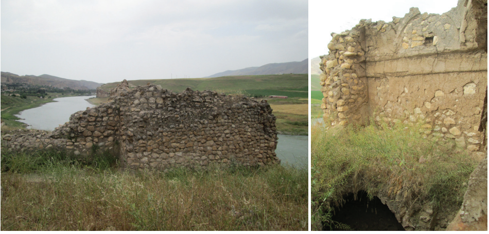
Fot. 7: (a - b) Şeyh Sultan Zaviyesi kalıntıları (Demirtaş, 2016c.)
