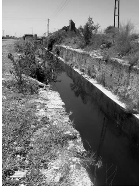
Res. 11 Anydros-Eudokias'a su getiren antik ana kanalın bugünkü betonlanmış hali, Kırkgözler Kanakları yakınları
