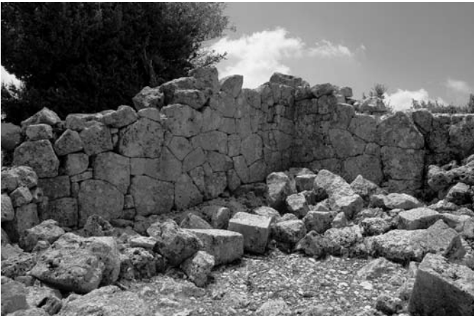
Res. 9 Gölcük Polygonal Duvarlı Yapı
