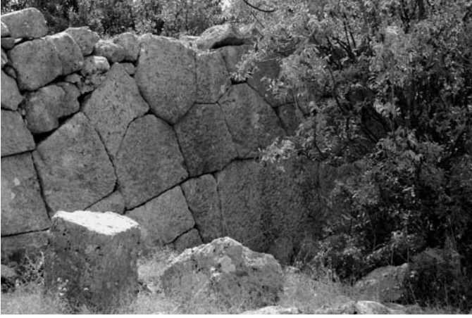
Res. 70 Kızılekinlik Polygonal Duvar Yapısı
