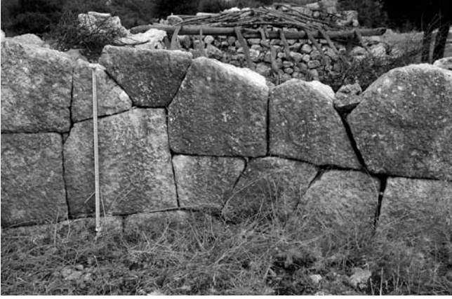
Res. 76 Ahatlı Polygonal Duvar Yapısı
