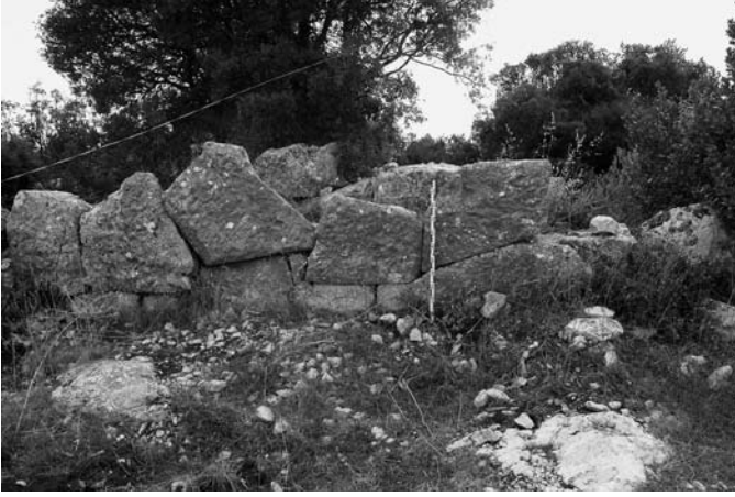
Res. 28 Erikliseki (batı) Polygonal Duvar Örgüsü
