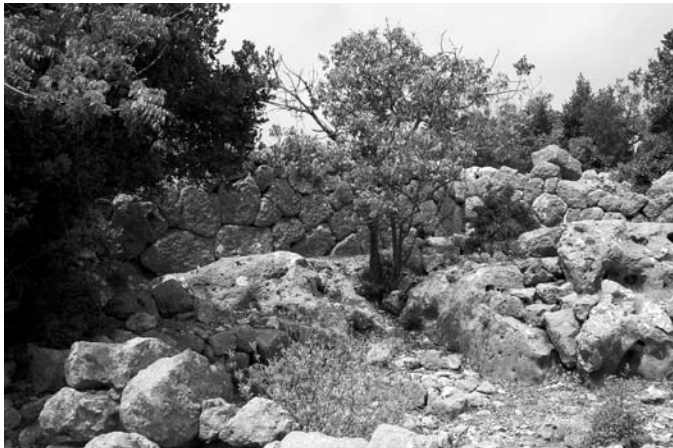
Res. 44 Duvararası Yapı
