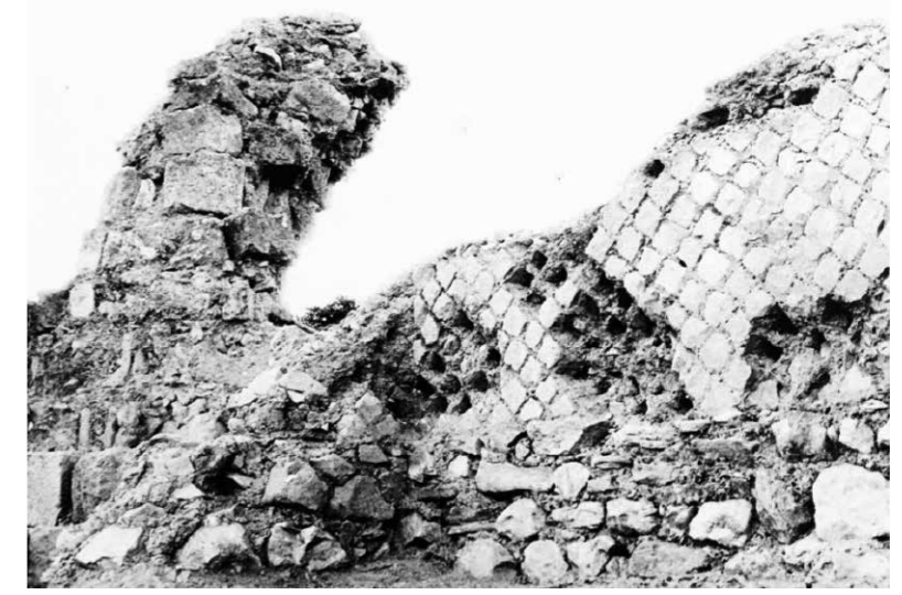
Fig. 5: Samosata'daki opus reticulatum tekniğinde örülmüş bir duvar (Özgüç 2009: Lev. 94 Fig. 209).
