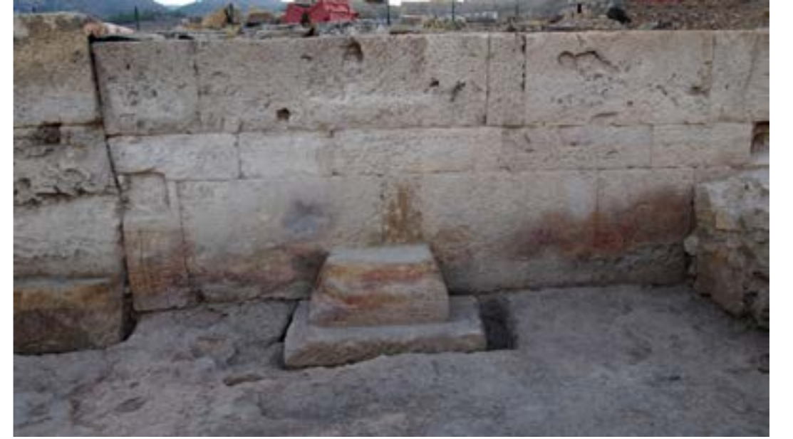
Fig. 15. Ploutonion'un temenos duvarı.
