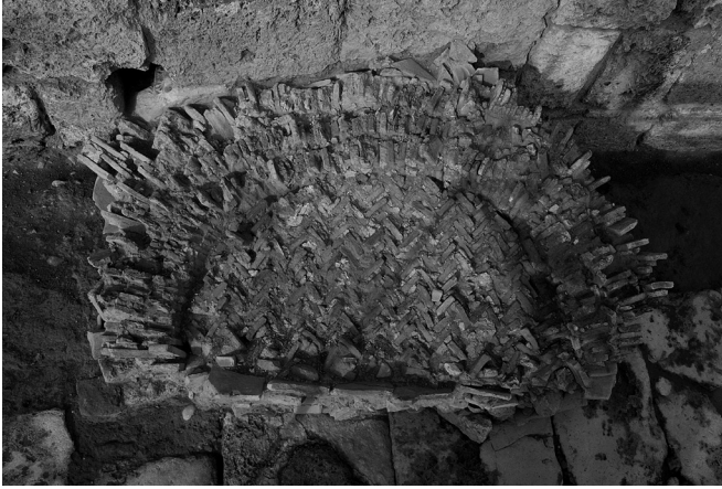
Res. 12 Tapınak A Doğu Sokak üzerine MS 7. yy başı depreminde yıkılan sağır kemerin in situ hali
