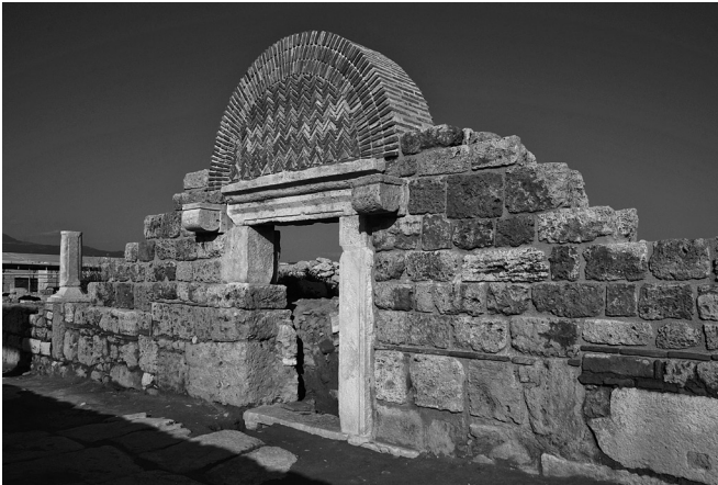
Res. 13 Tapınak A Doğu Sokak üzerindeki yapıya ait olan sağır kemerin restorasyon sonrası durumu
