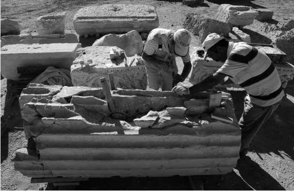
Res. 24 Kuzey (Kutsal) Agora Doğu Portiğine ait sütun tamburunda kırk parçalarının birleştirilmesine ve sağlamlaştırılmasına yönelik restorasyon çalışmaları
