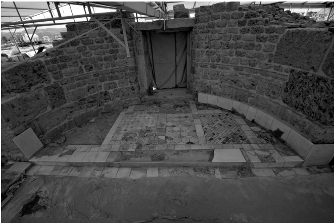
Res. 19 Güneydoğu apsiste yer alan opus sectile ve döşemenin restorasyon sonrası durumu
