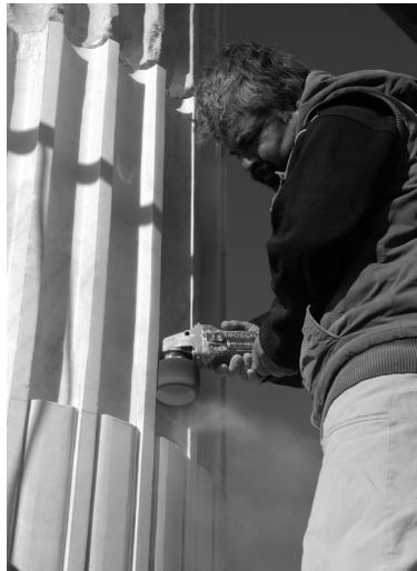
Resim 25 Kuzey (Kutsal) Agora Doğu portiğinde ayağa kaldırılan sütunda yapılan eksik tamburun yeni mermerden yapılması ve işlenmesi safhası
