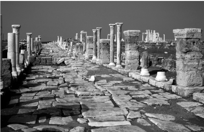
Res. 7 Restorasyon sonrası Suriye Caddesi ve depremde cadde üzerine yıkılan traverten ayağın in situ durumu
