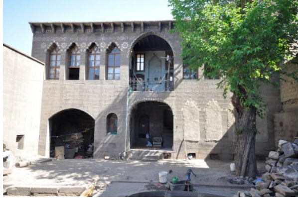
Foto:1- Sait Paşa Konağı'nın (Süleyman Nazif Evi'nin) Harem Bölümü Avlusu'nun Kuzey Kanadındaki Mekânların Genel Görünüşü.
