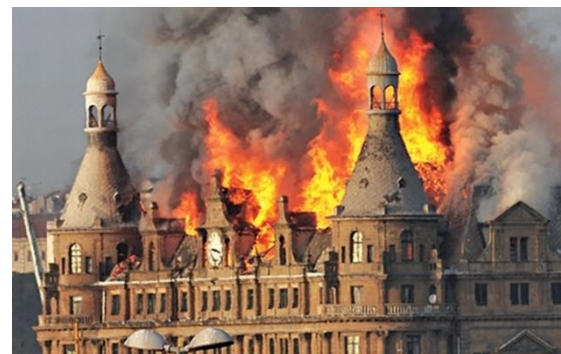
Şekil 7 a. Haydarpaşa Gar binasında yangın
