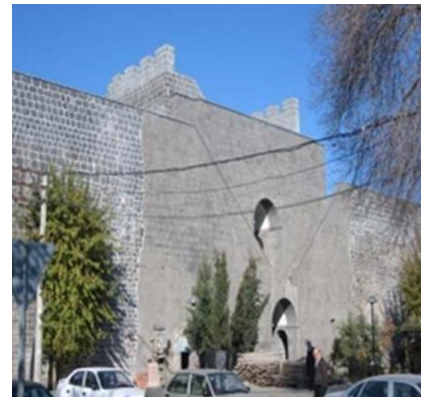
c. Taş duvara sıva uygulaması
