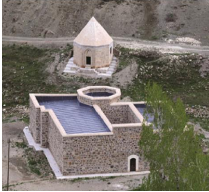
Şekil 25. Evliya Bey Medresesi onarım sonrası
