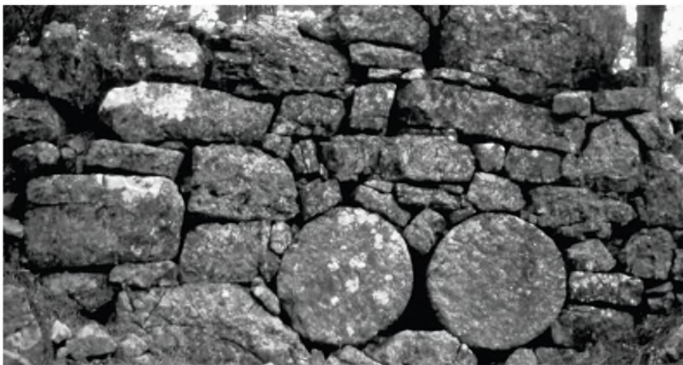
8. Mauerabschnitt im Nordosten mit verbauten Säulen
