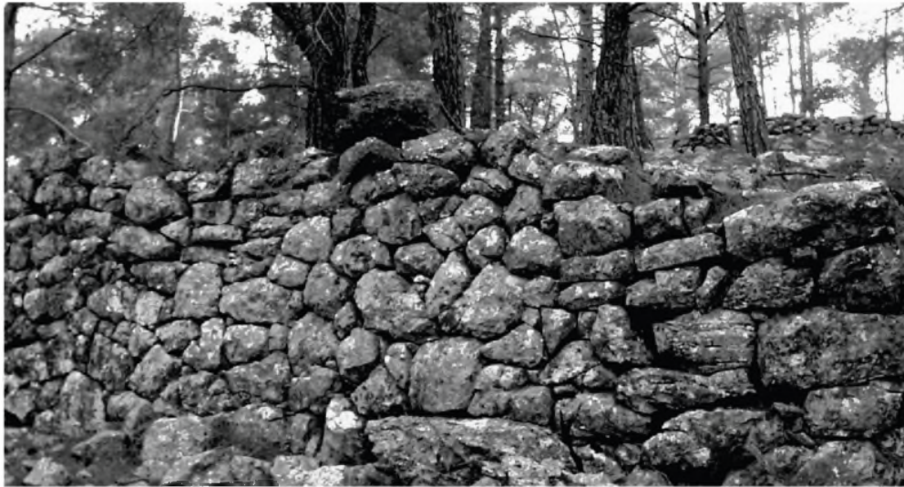
7. Hellenistischer Mauerring im Nordosten
