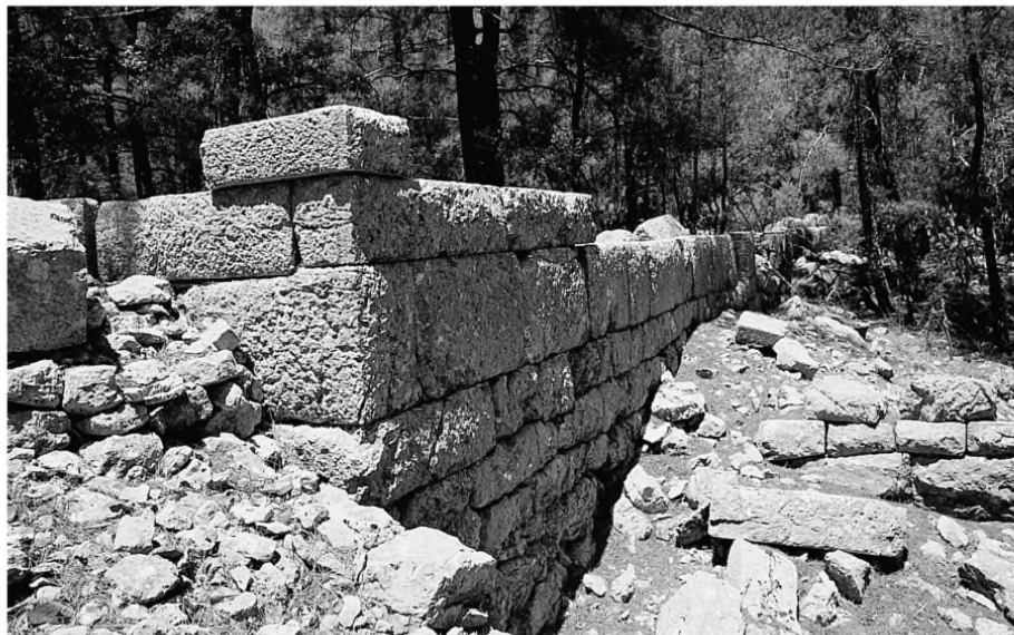
11. Außenmauern der Agora im Südosten
