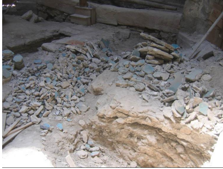
Fotoğraf 14: Hanikah onarım öncesi. (Konya Vakıflar Bölge Müdürlüğü'nden alınmıştır)
