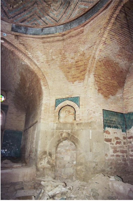
Fotoğraf 18: Kuzey batı köşe onarım öncesi. (Konya Vakıflar Bölge Müdürlüğü'nden alınmıştır)
