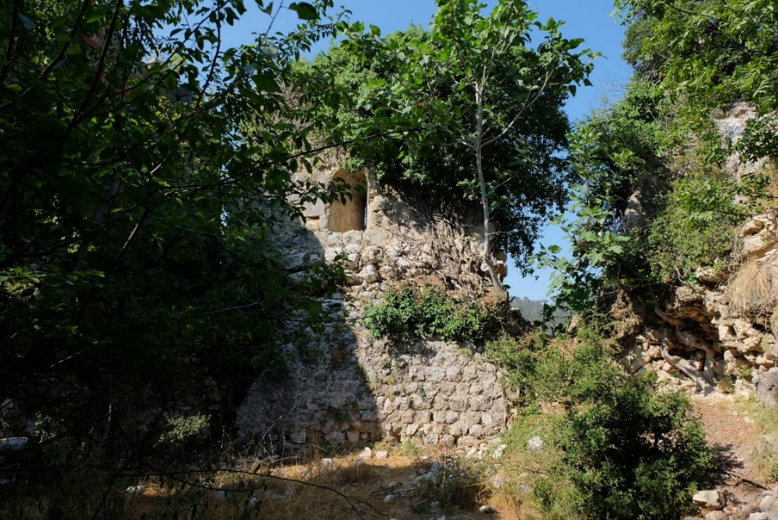
Foto 25. Sinap Kalesi (Çandır Köyü Civarı) İçten Görünüş - Kuzey Duvar
