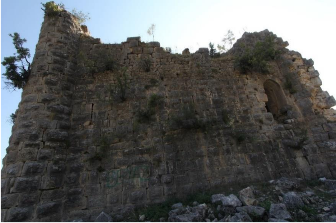
Foto 8. Kuzey Cephe - II. Kat Girişi
