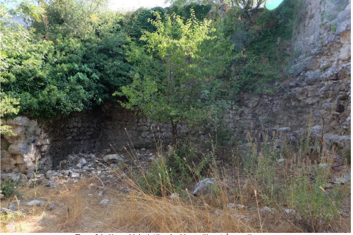
Foto 26. Sinap Kalesi (Çandır Köyü Civarı) İçten Görünüş
