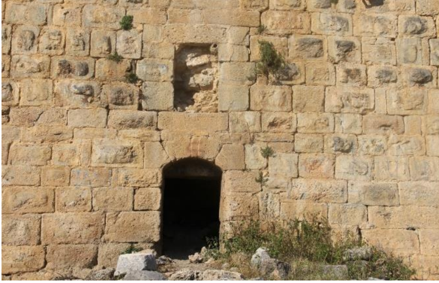
Foto 11. Güney Cephe - I. Kat Girişi
