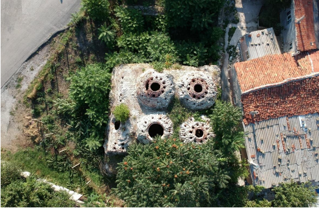
Fotoğraf 2: Keşan Eski Hamam, havadan genel görünüş ( Ünsal Yücel'den).
