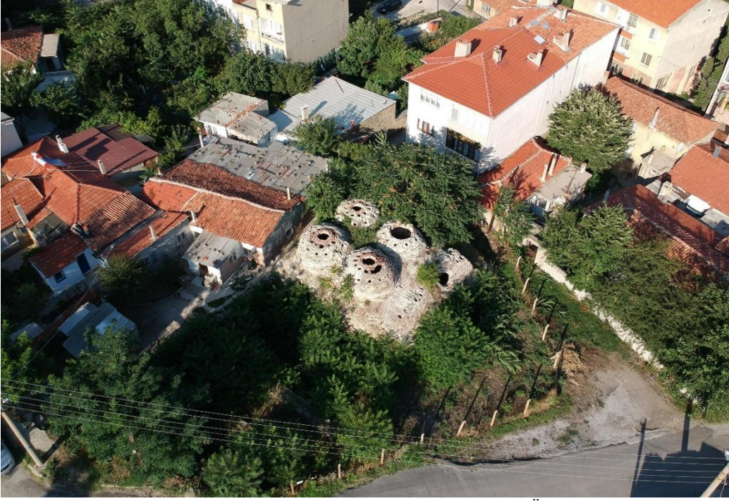
Fotoğraf 1: Keşan Eski Hamam, havadan genel görünüş ( Ünsal Yücel'den).
