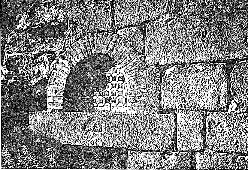
Res. 6 — Hanıkahın cephesindeki küçük kapı (foto : Y. Önge)
