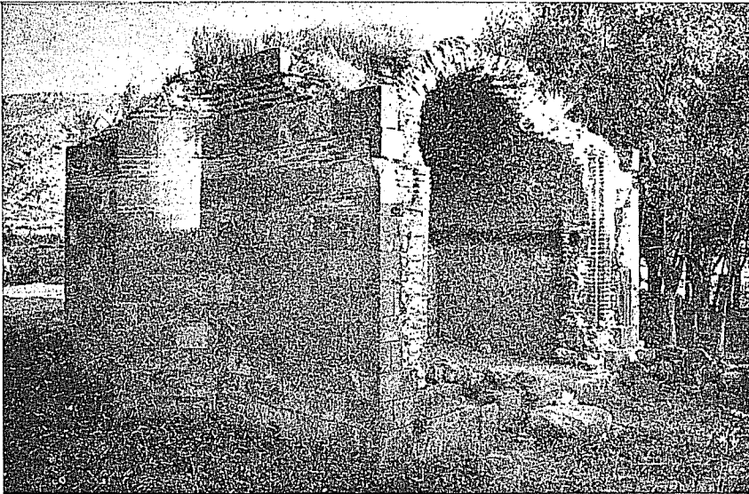
Res. 4 — Eyvan türbe (foto: Y. Demiriz)
