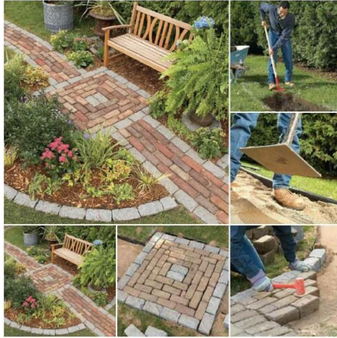
Şekil 3. Tuğlanın peyzajda yeniden kullanımı (Build a brick path, 2020)
