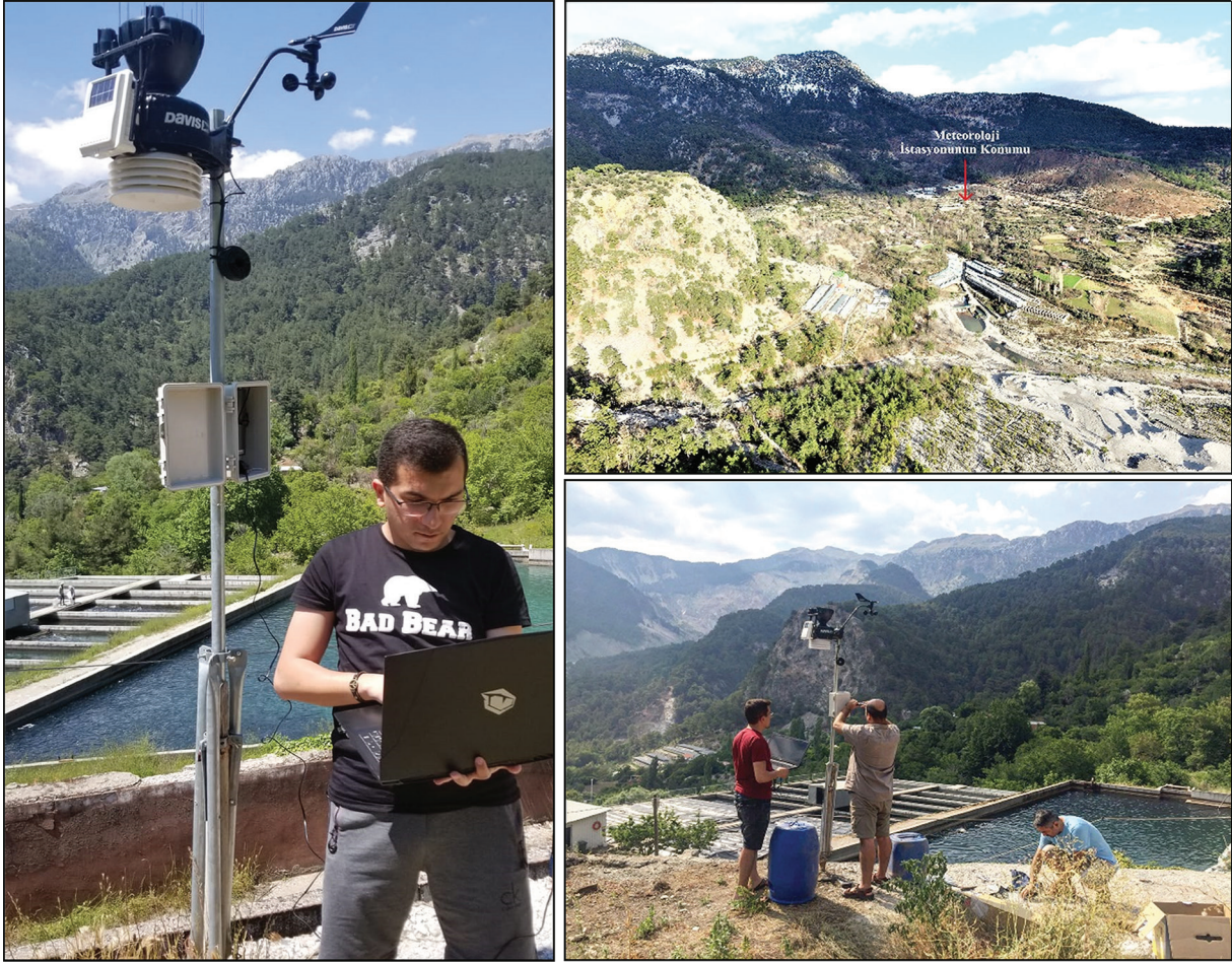
Şekil 2. Söğütüdere OHGI'nin kurulumu ve konumu. Figure 2. Installation and location of Söğütüdere AWOS.
