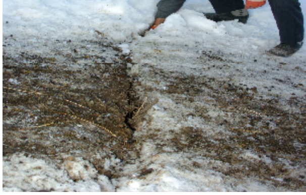
Şekil 9: Sütlüce mezrasında depreme bağlı gelişen heyelan çatlağı, bakış yönü K.
