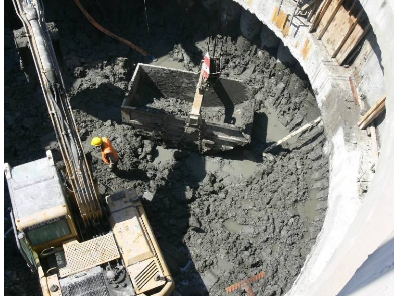
Şekil 4. Kadıköy S1C şaftı kazısı . Figure 4. Kadikoy S1C shaft excavation.
