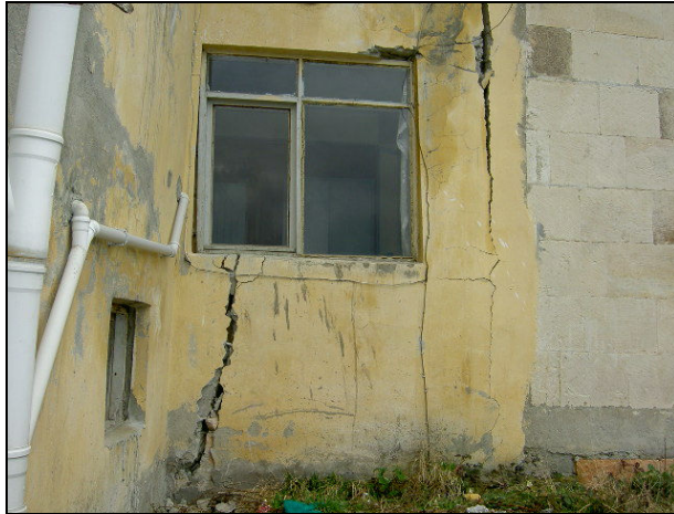
Şekil 8: Kayma Sonucu Çevredeki Binalarda Oluşan Yapısal Hasarlar Figure 8: Structural Damages to Buildings due to Slope Failure
