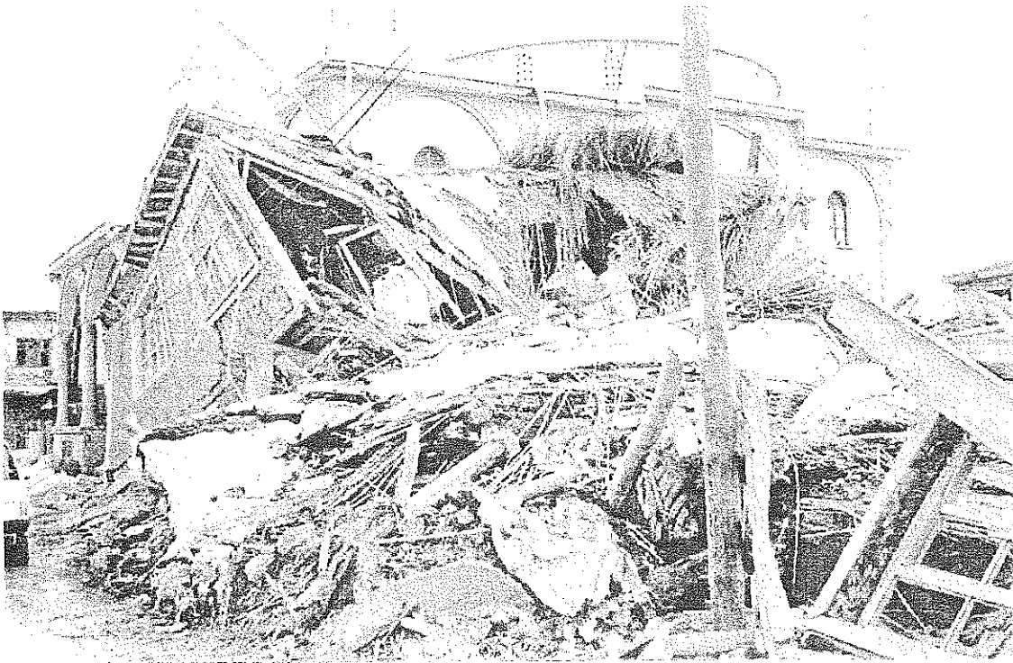
Resim 4. Eber'de yıkılan kerpiç bina. Photo 4. Damaged adobe building in Eber
