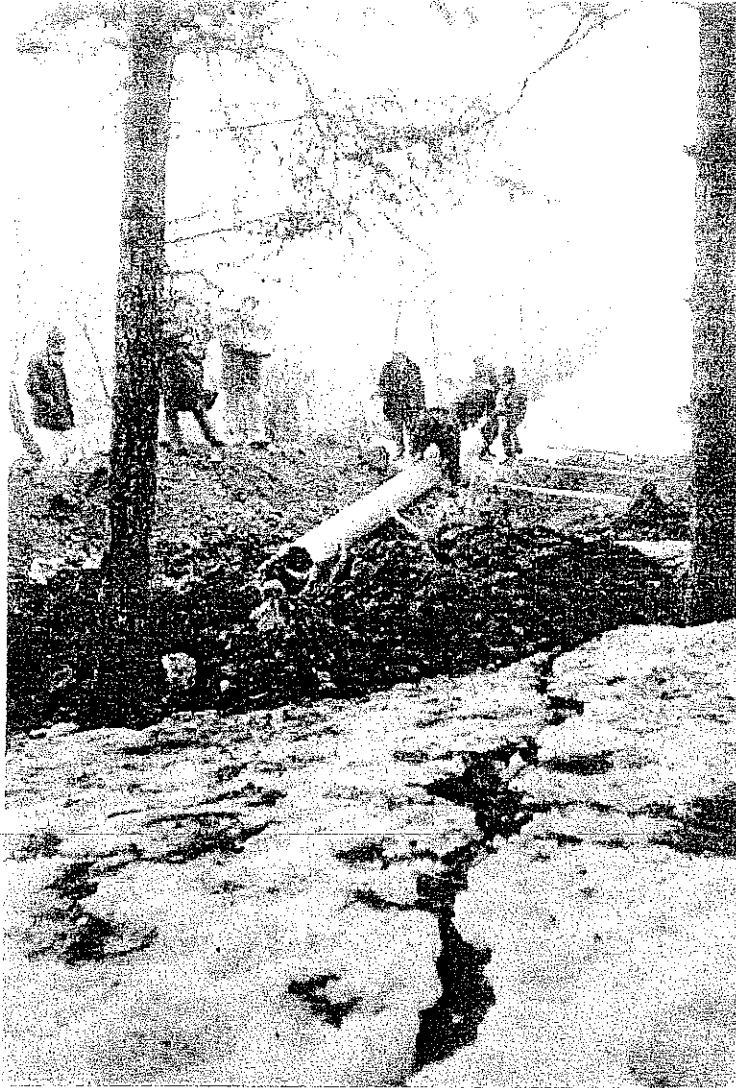
Resim 5. Çay ilçesinin güneybatısında depremden hasar gören su borusu ve hasara neden olan yüzey kırığı. Photo 5. Damaged water pipe-line at southwest of Çay and surface faulting.
