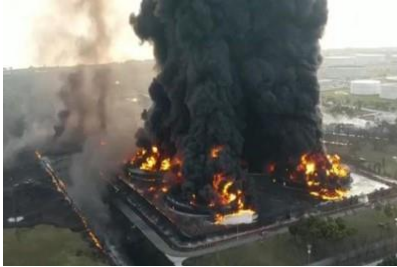
Şekil 2: Endonezya'da petrol rafinerisinde meydana gelen patlama ve yangın (BBC 2021)
