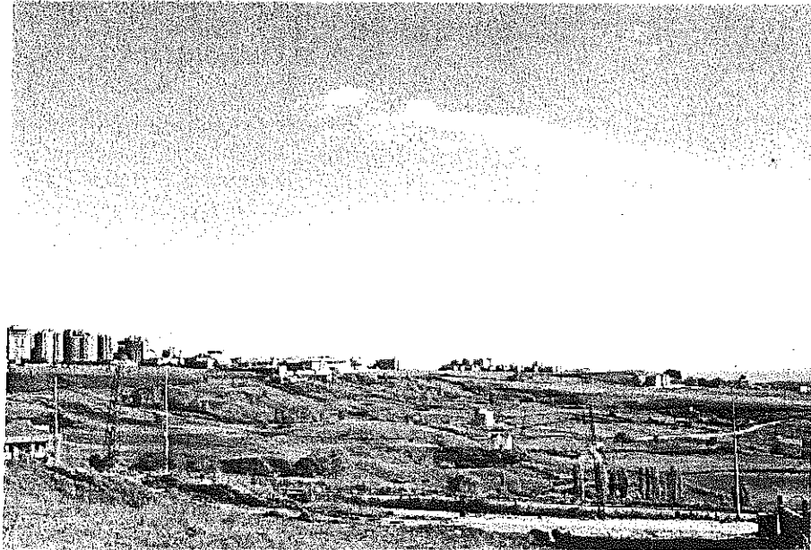
Şekil 5. Heyelan tehlikesi yüksek Devebağirtan heyelanı. Figure 5. High landslide risky at Devebağirtan landslide.
