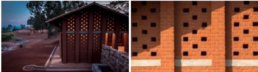
Şekil 3. Muyinga Kütüphanesi CEB kullanımı (B.C. Architect and Studies, 2012b)
