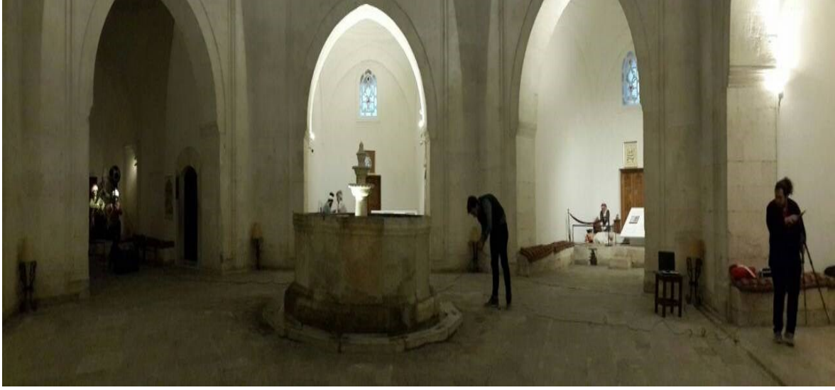
Şekil 6: İç mekânda kullanılan yüzeyler mikroorganizmaların yuvalanmasına engel olması için özellikle sert malzemelerden üretilmiştir, insan seviyesinde düz ve pürüzsüzdür ( http://yapiakustiklab.atilim.edu.tr/ ).
