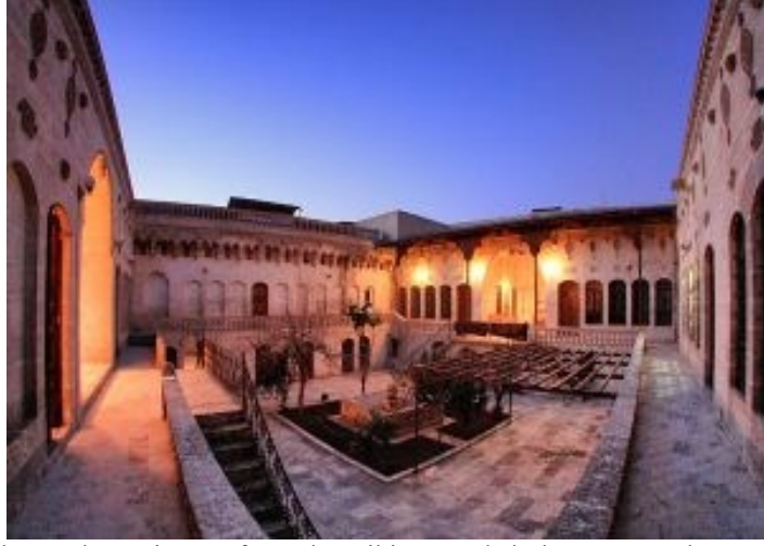
Şekil 5a: Şahap Bakır Evi, Ş. Urfa. Avluya iki yönünde bulunan Eyvanların orta aksında bulunan su havuzu ile havalandırma ve soğutma sağlanmaktadır. (Fotoğraf T.B.M.M Kültür Sanat ve Yayın Kurulu arşivi.)
