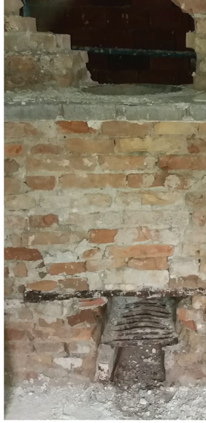
G. 7: Manol Evi hamamı, mutfak ile hamam arasındaki duvar (Söke Belediyesi Arşivi, 2020)
