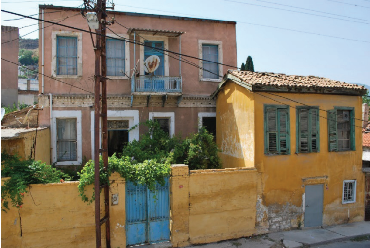
G. 1: Manol Evi, Alay Sokağa bakan cephe. Restorasyon öncesi. (Söke Belediyesi Arşivi, 2010)
