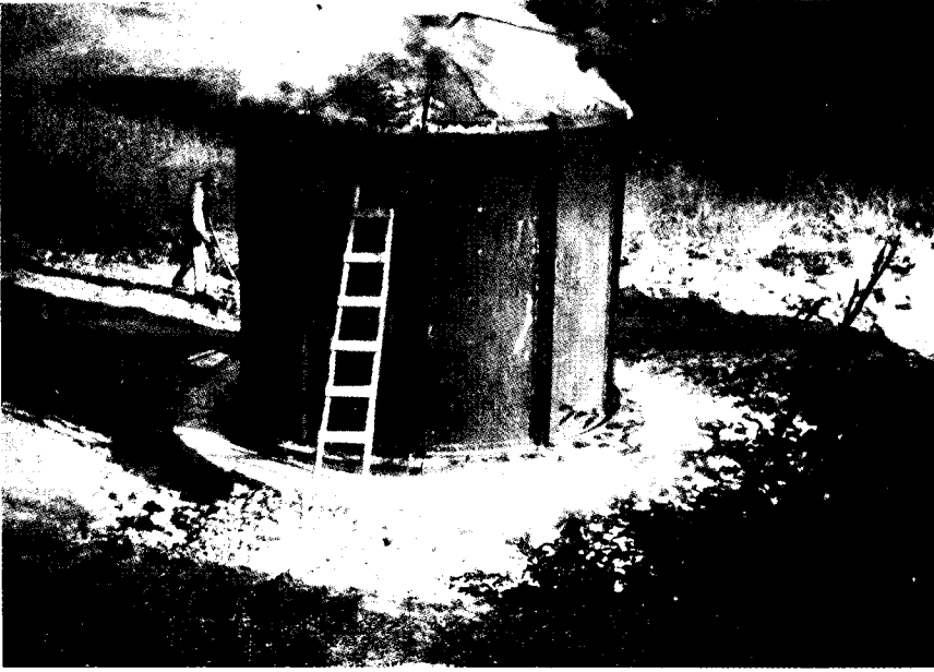
Resim 8 : Seyyar madeni ocağın yanma esnasındaki durumu. (Foto : Berkel)
