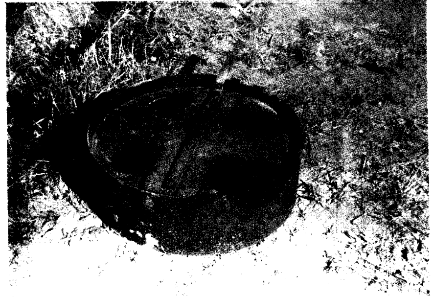
Resim 6 : Seyyar madeni kömürleştirme ocağının bacasının üst kısmında bulunan hava ayarlama tertibatı.
