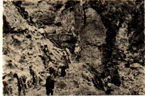
ŞEKİL 15. Mulağa (Trabzon) orman yolunun el ile inşaatı
