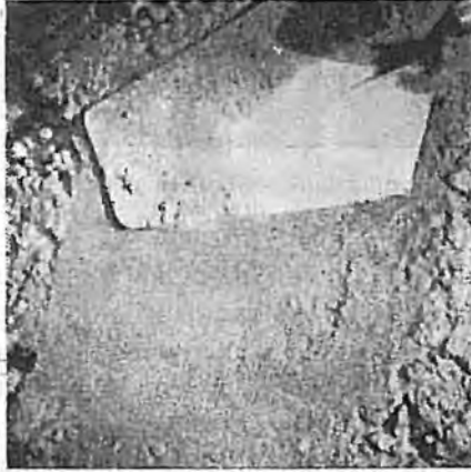
Resim: 2 Çimento ile agregat'ın en uygun ve ekonomik bileşim kıvamının mala yardımıyla kontrolü.
