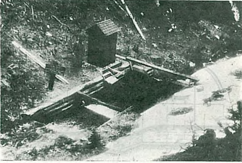
Şekil : 10 Önemli kısımları ile Bir Akış Ölçme İstasyonunun Görünüşü Frazer Araştırma Ormanı, Kolorado. (Foto - Özyuvacı)
