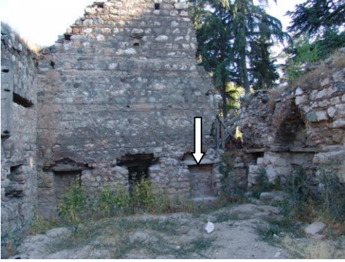
Şekil 3. Tokat-Gülbahar Hatun Kulliyesi'nin restorasyon öncesi son durumu. Meşe örnekleri duvar içi (beyaz ok) ve cam üstlerinden alınmıştır.
