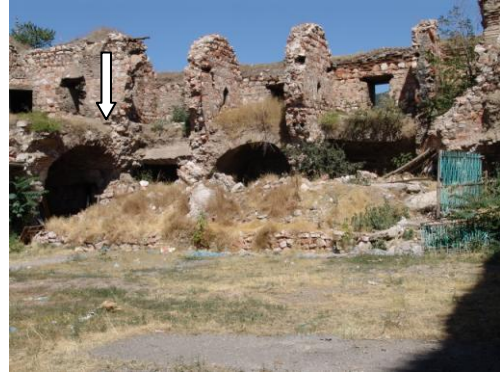
Şekil 2. Tokat-Deveciler Hanı'nın avlusu. Örnekler giriş kattaki iç avlunun duvar içleri ve pencere üstlerinden alınmıştır.
