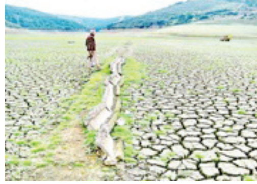
Şekil 11. Cebeci deresinin ağzından başlayan ve orta kısmı sedimentle gömülmüş olan beton kanal (Alibey deresinin yatağı fotoğraftaki iş makinesinin yanındadır (2007)).
