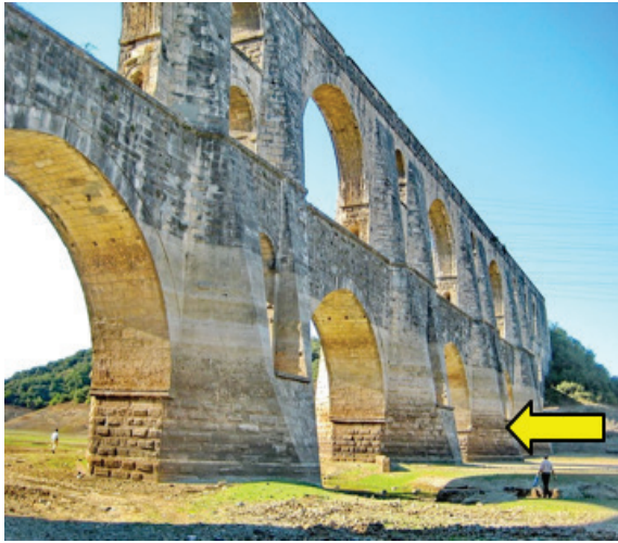
Şekil 15. Mağlova kemerinin mansaptan görünüşü (2007). Ayaklardaki üçgen formların uçları Şekil 14'e göre bir taş sırası kadar gömülmüş durumda olup karşılaştırılan ayaklar okla gösterilmiştir. Figure 15. View of Mağlova aqueduct from downstream (2007). Triangle forms compared with in the figure 14 is shown with an arrow.
