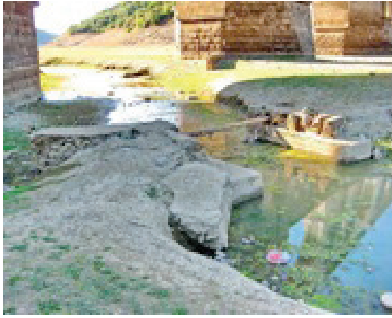
Şekil 10. Eski araba yolu ve köprü ayakları (2007) Figure 10. Old carriage way and bridge foot (2007)
