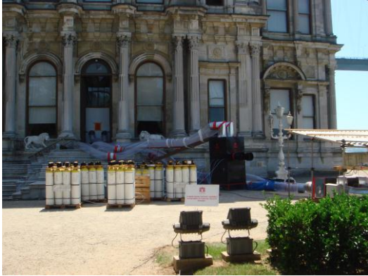
Şekil 5. Fumigasyonda kullanılan sirkülasyon fanları ve gaz tankı Figure 5. Circulation fans and gas tank used in Fumigation
