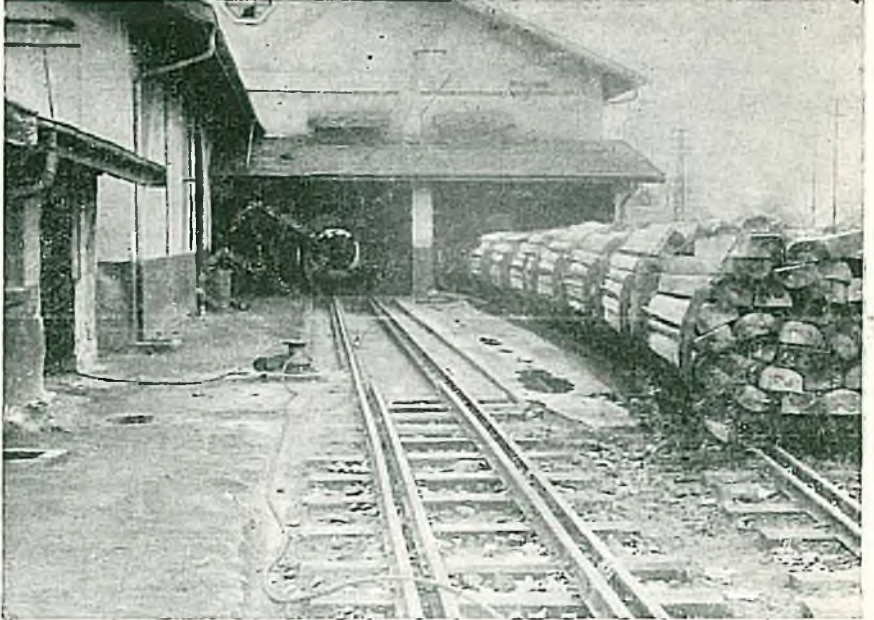
Resim 8 : Birbiri ardınca yedi adet vagonun traverslerle empenye kazanına sevki. (Foto: A. Berkel)
