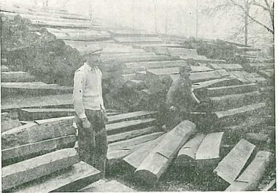
Resim 4 : Sabotaj ameliyesine tabi tutulmuş Traversler.
