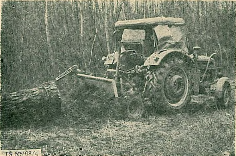
Resim 3: Gövdelerin tek tek çekilmesi.
