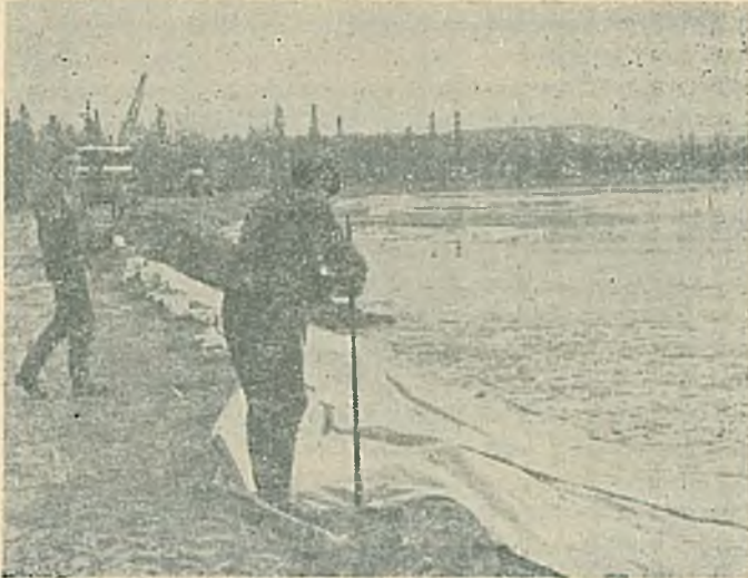
Resim 8. Serilmiş bulunan Polifelt TS rulolarının kazıklarla tesbiti.
