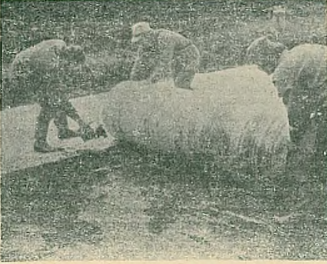
Resim 1. Polifelt TS rulolarının bndirmeli olarak birleştirilmesi.
