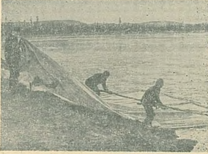
Resim 7. Polifelt TS rulolarının nehir kıyısına serilmesi.
