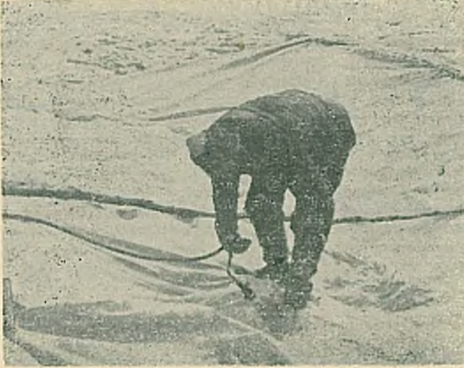
Resim 9. Polifelt TS rulolarının kaynakla bindirmeli olarak birleştirilmesi.
