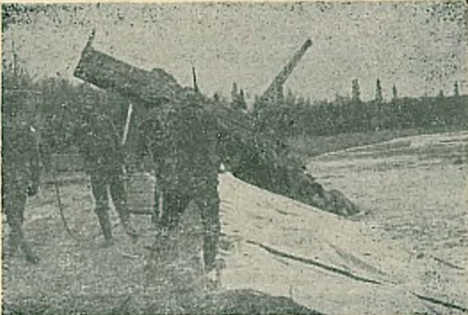
Resim 10. Serilmiş bulunan Polifelt TS rulolarının üzerine kırma taş dökülmesi.
