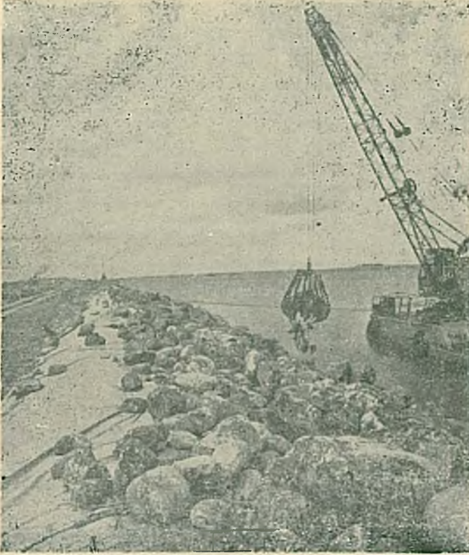
Resim 13. Polifelt TS rulolarının üzerine taşların yerleştirilmesi.
