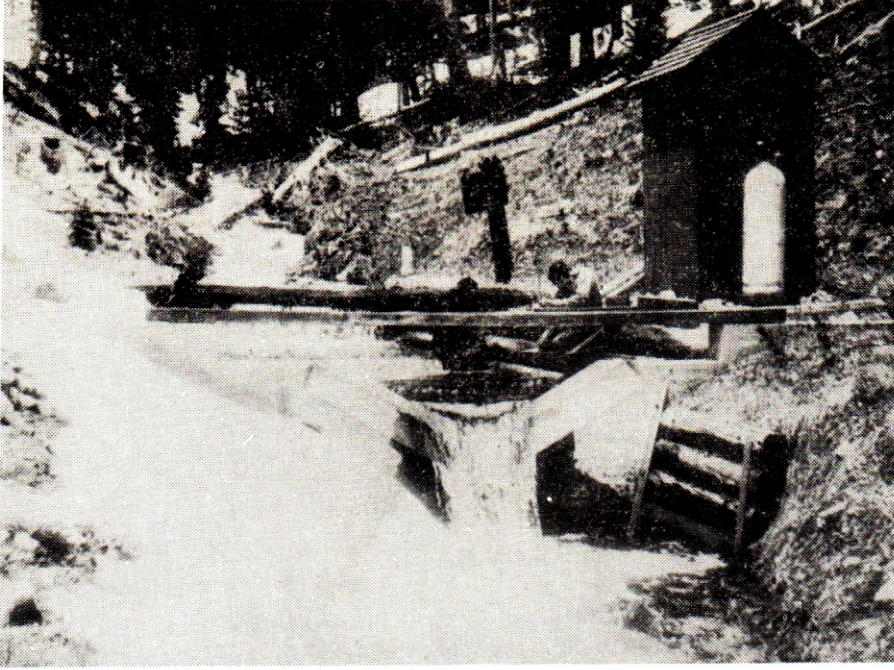
Resim 2. Havza Metodlarında dere akımlarının ölçüldüğü bir ölçme istasyonu. (Lexen-creek yağış havzası, Kolorado).
