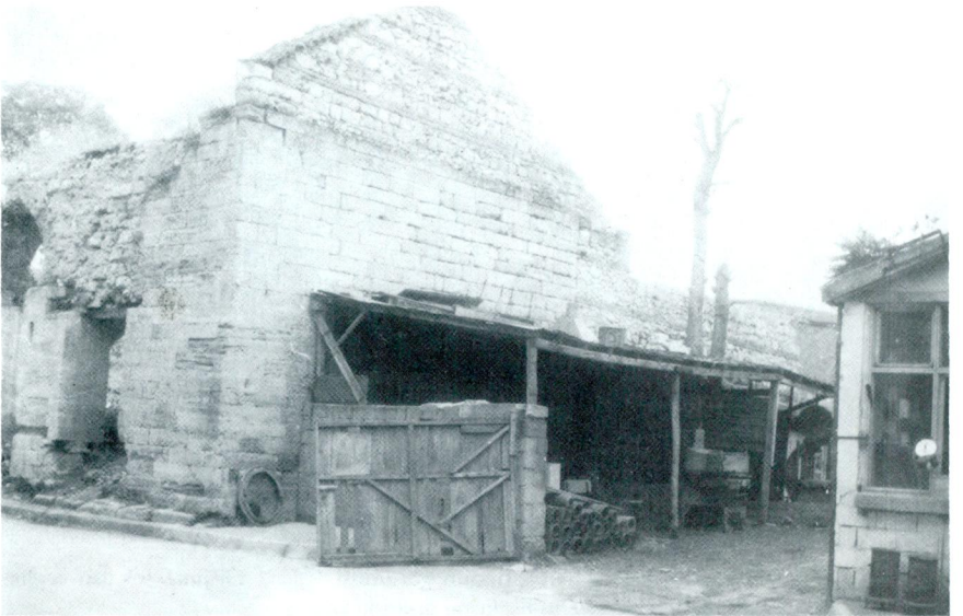
Res. 14 – Ekmekçiöglü Kervansarayı İstanbul Caddesi 19 no.lu dükkanın 1975 restorasyonu sırasında temizlenmiş hali.
