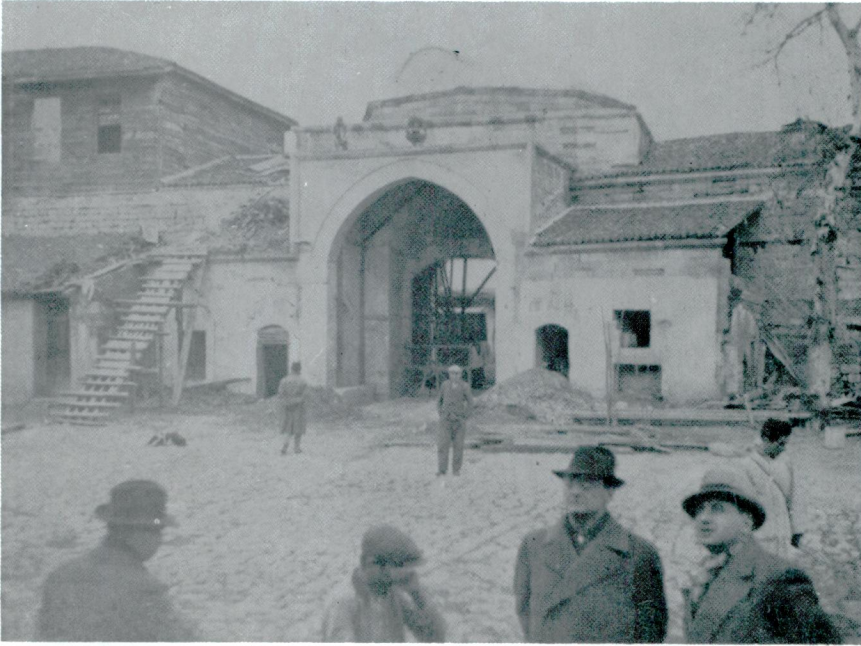
Res. 4 – Ekmekçiöğlü Kervansarayı (1937). Giriş mekanının avludan görünüşü, muhdes kubbe yıkılmadan ahşap meşruta kaldırılmadan önceki hali. Kaynak : Sn. Prof. Feridun Akozan fotoğraf arşivi.
