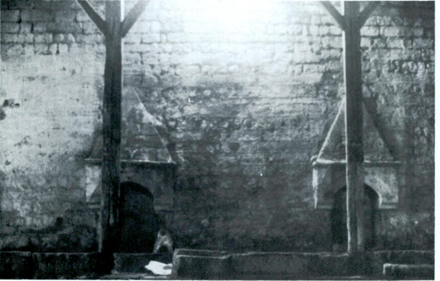
Res. 18 – Kapalı han kısmında ocak (bu ocaklar İstanbul, Arasta odalarındaki ocaklara benzemektedir). (Bkz. Ocak rölövesi şekil 16).
