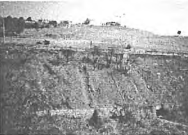
Şekil 4: Yol şevlerinde yangın Figure 4: Fire on the roadside
