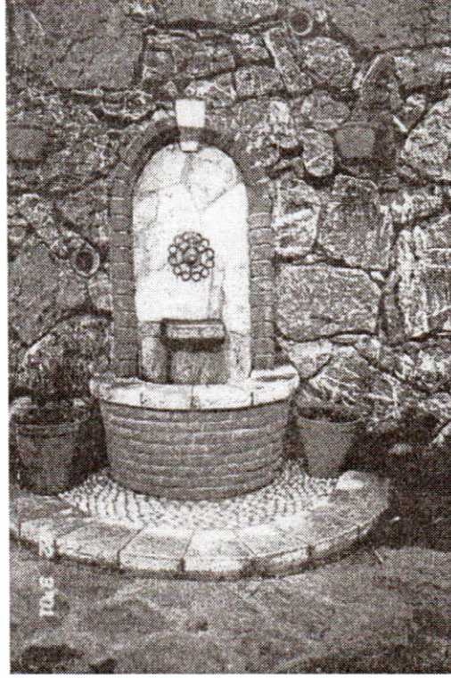
Fotoğraf 5: Kayrak taşı, tuğla, küfeki taşı ve çakıl kullanılarak oluşturulmuş bir çeşme detayı.
