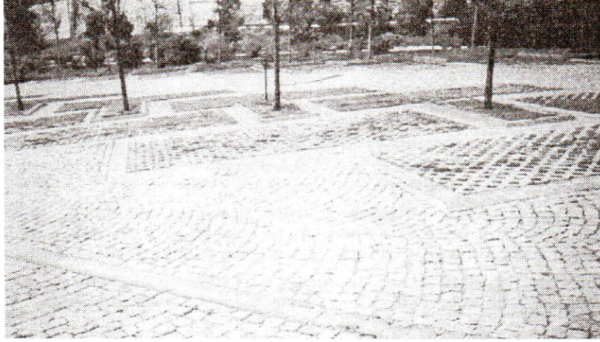
Fotoğraf 6: Doğal (granit parke) ve yapay (tuğla, çim taşı) döşeme malzemelerinin kombine edildiği bir otopark uygulaması.
