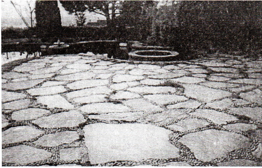
Fotoğraf 4. Süs havuzu yanında, yine su kökenli bir malzeme olan çakıl ile derzlendirilerek döşenmiş kayrak taşları.
