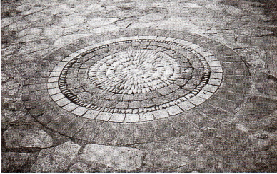
Fotoğraf 2: Beton derzli kayrak taşı uygulanmış bir zemin kaplamasında, taban tuğlası, traverten, çakıl, granit parke ve tekrar çakıl (dıştan içe doğru) kullanılarak oluşturulmuş bir desen çalışması
