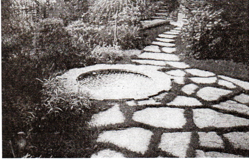
Fotoğraf 3: Küfeki taşı ve podima çakılı ile yapılmış süs havuzu ve çevresindeki çim derzli kayraktaşı kaplanarak oluşturulmuş alan.
