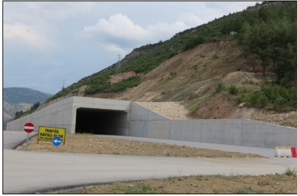
Fotoğraf 1. Amasya şehri batısında yapımı devam eden çevre yolunda yamaçtaki akma sonucu yapay tünel yapılarak sorun çözülmeye çalışılmaktadır.
