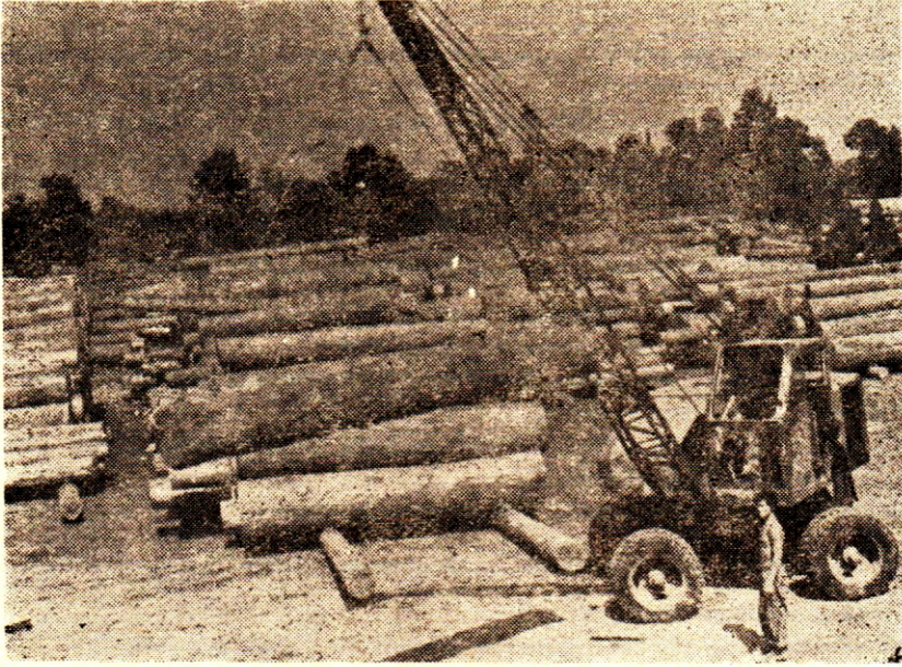
Resim 1.14. Bir hareketli döner kreynle tomruk istifleme.
