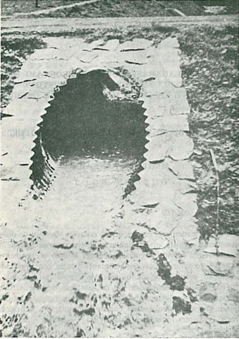
Oluklu çelik saçtan yapılmış bir menfez, menfez yerinde kolay ve çabukca yapılmıştır.
