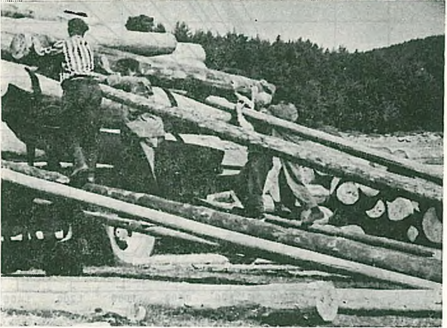
Resim 3. İğne yapraklı ağaç tomruklarının kamyona elle yüklenmesi (Bolu-Aladağ)
