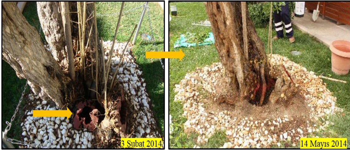
Resim 3. Nar ağacının kök alanında gerçekleştirilen tesviye ve temizlik çalışmaları. Picture 3. Levelling and cleaning works around root collar of the tree.
