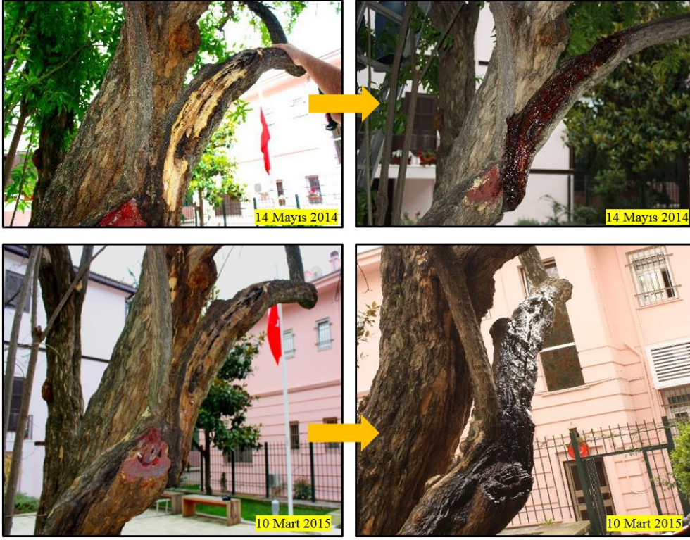
Resim 8. Temizlenen yara yüzeylerinin çam katranı ile kapatılması. Picture 8. Covering with pine tar of cleaned wound surfaces.
