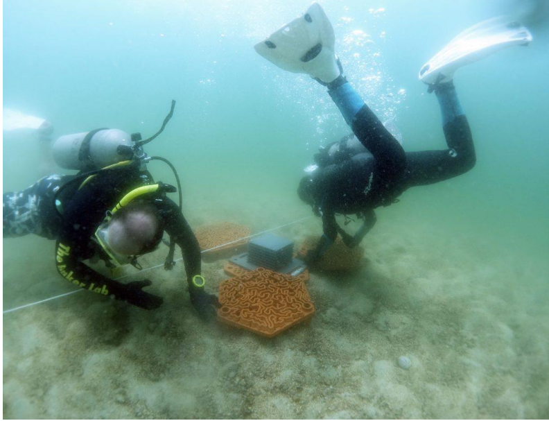
Resim 6. Hoi Ha Wan Deniz Parkı'ndaki bir mercan resifini onarmak için geliştirilen altgen seramik karoların körfez tabanına yerleştirilişi, (URL 20).
