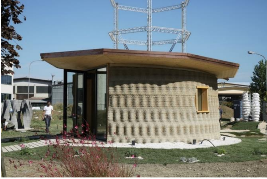
Resim 1. 2018'de piyasaya sürülen ilk üç boyutlu mimari konut modeli olan Gaia, (URL 15).
