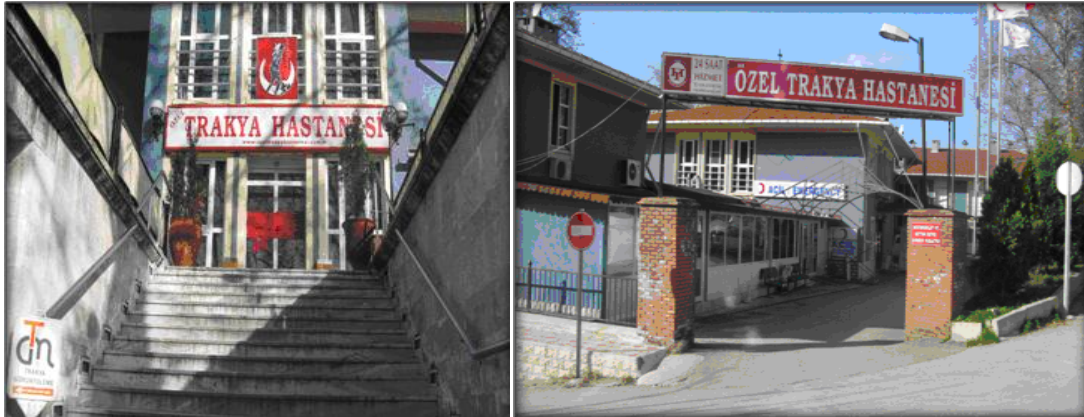
Şekil 6. Hastane giriş alanı Figure 6. Hospital entrance area
