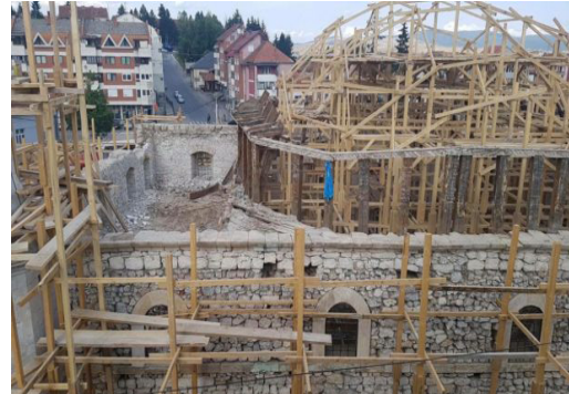
Fotoğraf 7. 2016-2018 TİKA Restorasyonunda Caminin Kubbесinin Yenilenmesi
