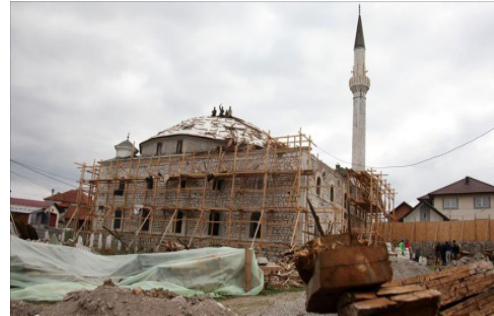
Fotoğraf 7. 2016-2018 TİKA Restorasyonunda Caminin Kubbесinin Yenilenmesi
