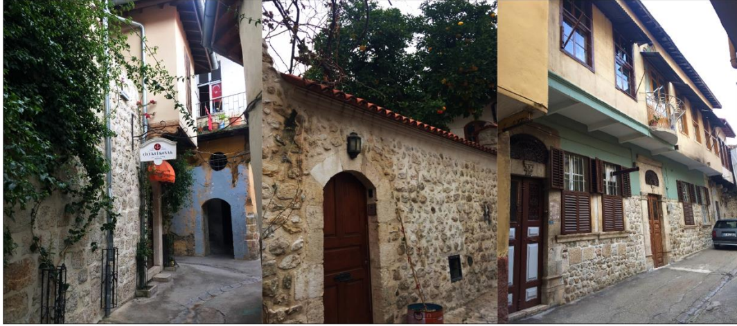
Şekil 5. Sınırları oluşturan yapı duvarları (Orijinal, 2017).
