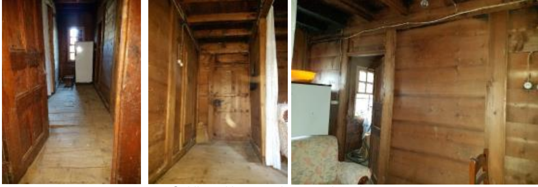
Şekil 14. Hayat mekanının duvarları
